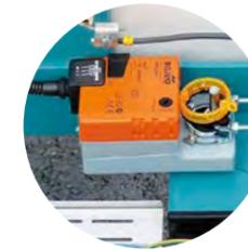
Zuluftklappe mit Stellmotor
